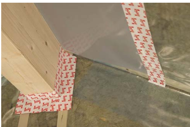
Fig. 6 Eksempel på bruk av Dampsperre Tape FLEX for tetting rundt bjelkegjennomføring.
