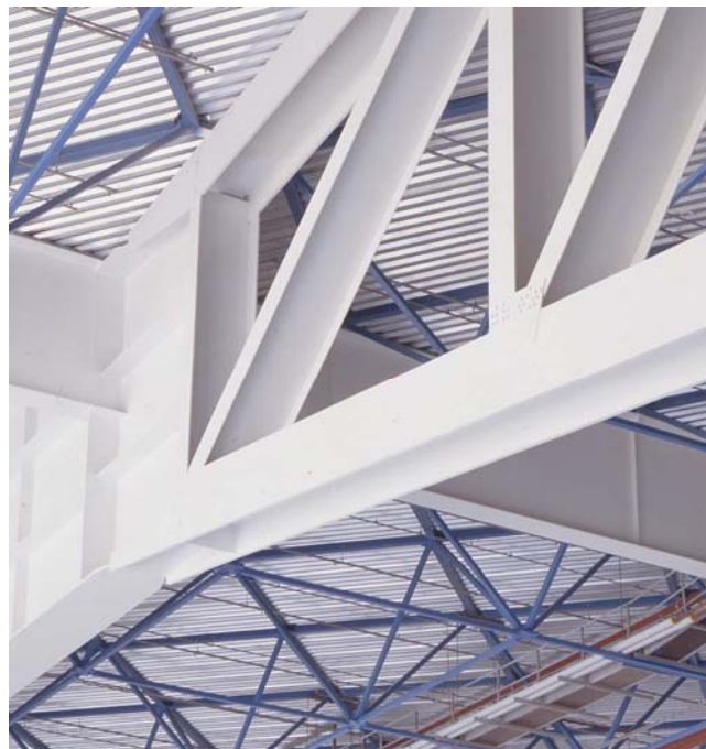
Fig. 1 Brannbeskyttende maling NON-FIRE S104 benyttet på stålkonstruksjoner.
