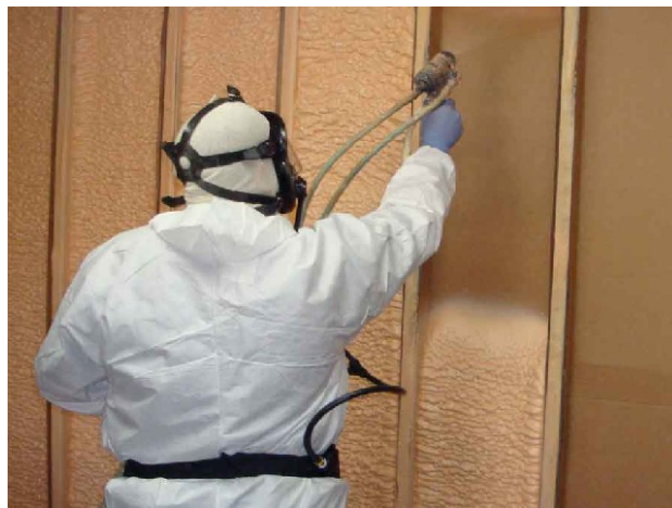
Fig. 1 Isolering av vegg med Lapolla sprayskum. Foto: Lapolla
